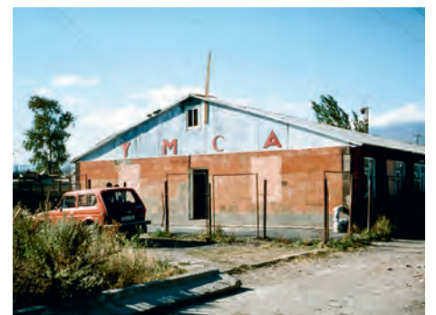
Altes Gebäude des YMCA Spitak
